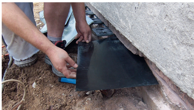
Einbringen einer Abdichtungsplatte bei nachträglichem Einbau einer Horizontalsperre mittels Mäuersägeverfahren
