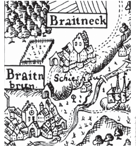
1229 erstmals urkundlich erwähnt, befinden sich die Reste der Burg Breitenegg auf einer Bergspitze beim Ortsteil Breitenegg heute in privater Hand.
