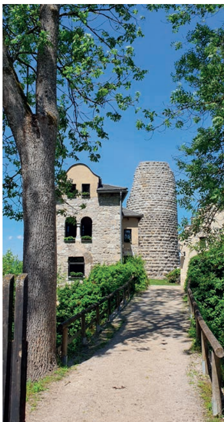
2 m dicke Mauern tragen den Bergfried der Burg Stein
