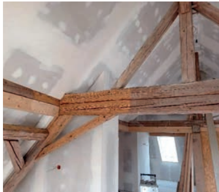
Holzbalken oder ganze Dachstühle können mittels Trockeneisstrahlen schonend gereinigt werden
