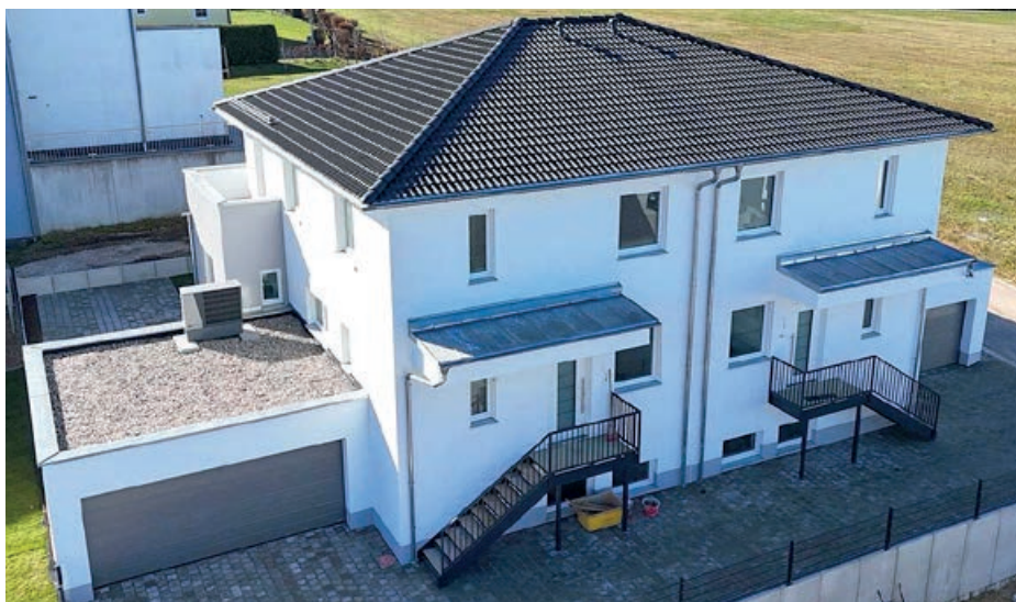
Ganz frisch abgeschlossen: unser erstes eigenes schlüsselfertiges Projekt in Daßwang!
