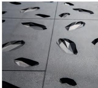
Gefertigt wurden die Rohlinge im Laser Melting aus Aluminium, was im Vergleich zu konventionellen Verfahren deutlich günstiger war. Die additiv gefertigten Elemente mussten lediglich gestrahlt und plan geschliffen werden und waren ansonsten sofort einsatzfähig. Sie konnten einfach und schnell im Fassadenwerkzeug verbaut werden.
