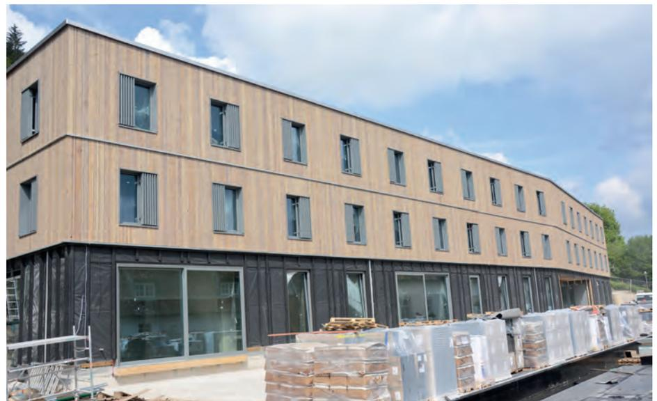
Der Holzständerbau „St. Wunibald“ mit Strohballeausfachung aus vorgefertigten Elementen umfasst inklusive Kellergeschoss eine Grundfläche von 2637 m<sup>2</sup>. Die Strohballen zur Dämmung kamen höchst regional aus nur 1,5 km Entfernung zur Baustelle.
